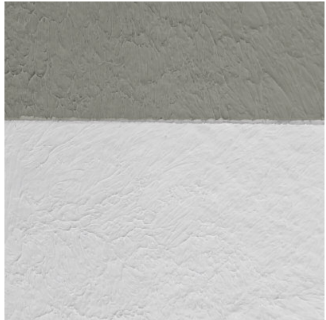
Ausgetrockneter Zustand: Die 2. weiße Schicht überdeckt vollständig die 1. graue Schicht. Mindesttrockenschichtdicke von 0,5 mm erreicht.
