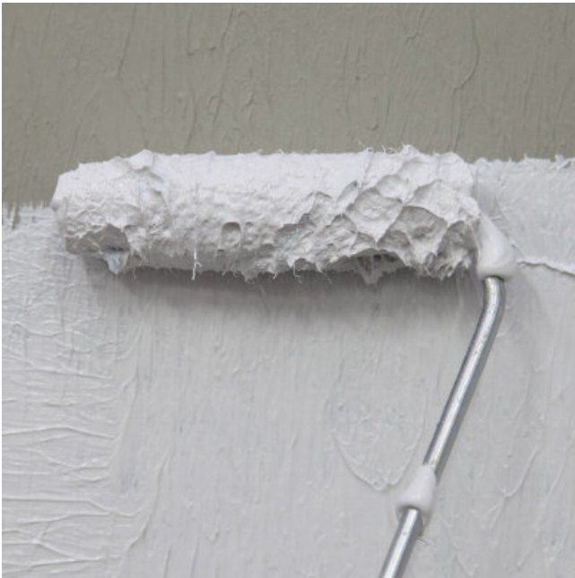
Nachdem die 1. graue Schicht abgetrocknet ist, wird die 2. weiße Schicht mittels Roller (Foto) oder Spachtel aufgetragen.
